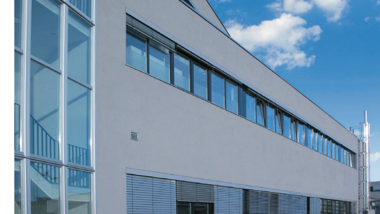
AluFusion omogućuje smišljeno realiziranje zamisli suvremene arhitekture, s prozorskim elementima od kata do kata bez ograda i spojnica.
